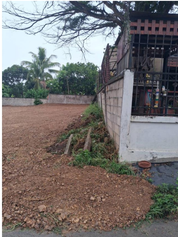
แนวหลังคาล้ำเขต
