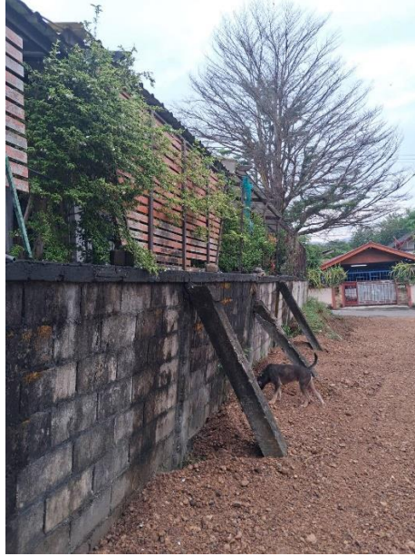
เสาคว่ำรั้วในพื้นที่ดิน 42462
